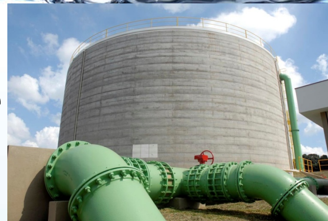
Reservatório Campo do Santana
