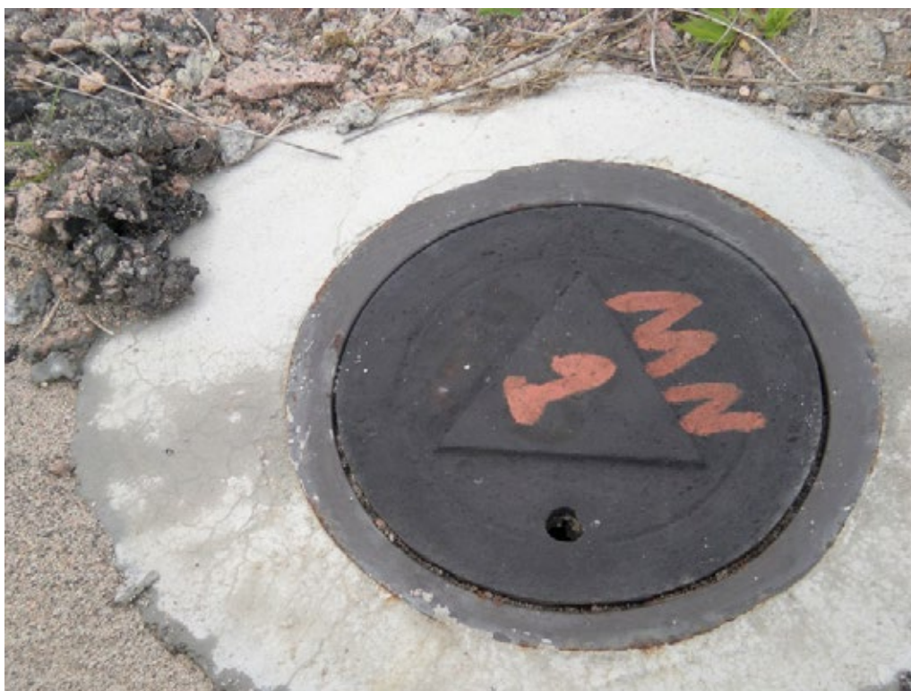
Figura 67. Tampa de uma bateria de placas de recalques. Fonte: COBA, S.A. / Banco de Imagens ANA
