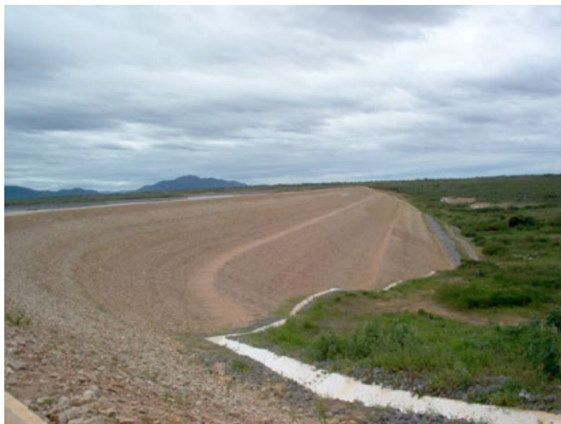
Figura 26. Talude de jusante revestido com cascalho (Barragem de Aracoiaba, CE). Fonte: COBA, S.A. / Banco de Imagens ANA
