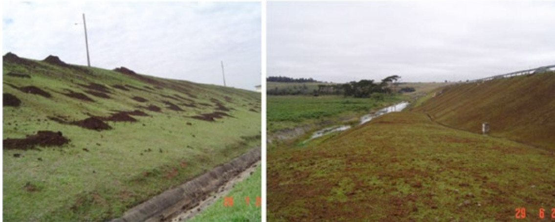
Figura 25. Ação de manutenção com reposição de cobertura vegetal. Fonte: COBA, S.A. / Banco de Imagens ANA
