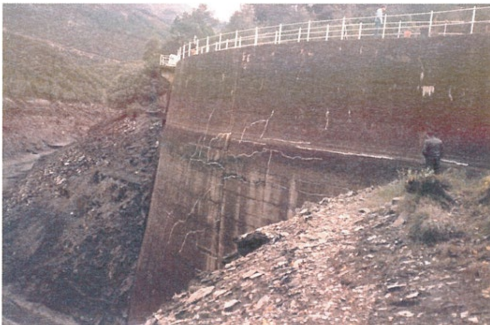
Figura 36. Fissuração numa barragem afetada por um processo expansivo do concreto da barragem do Alto Ceira, Portugal. Fonte: PEDRO, 2001 / Banco de Imagens ANA
