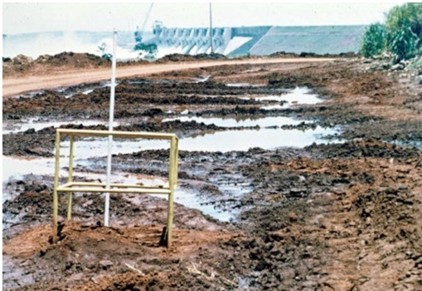
Figura 6. Surgência a jusante da Barragem de Água Vermelha, SP/MG, devido a uma camada de brecha basáltica muito permeável na fundação, logo após o enchimento do reservatório, em 1978.
