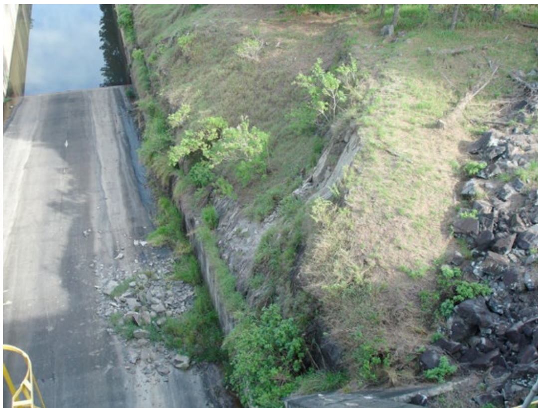
Figura 41. Queda de blocos de rocha do talude lateral sobre a calha do vertedouro da barragem de Jaguari da SABESP, SP.
