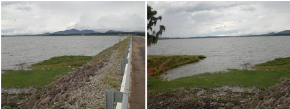
Figura 45. Acumulação de vegetação sobrenadante no reservatório, junto ao talude de montante da barragem.
