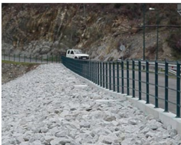
Figura 12. Deformação excessiva na crista da barragem indicando deslizamento do talude. Fonte: COBA, S.A. / Banco de Imagens ANA
