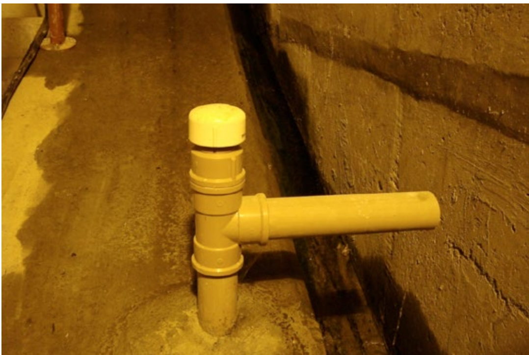
Figura 69. Terminal de dreno de fundação em “T” para facilitar as operações periódicas de limpeza.
