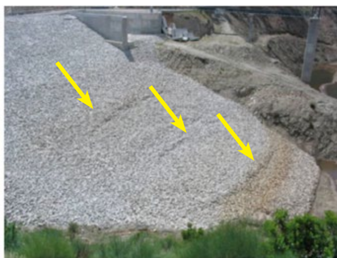
Figura 13. Deslizamentos no talude de montante. Fonte: COBA, S.A. / Banco de Imagens ANA
