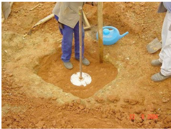
Figura 56. Instalação de uma placa de um medidor de recalques.
