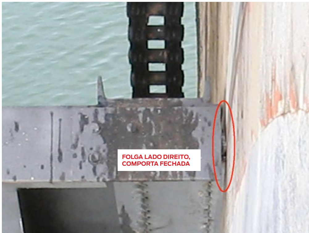
Figura 29. Roçamento da comporta com o pilar do vertedouro da barragem de concreto de pedra, BA afetada por RAA. Fonte: SBB Engenharia / Banco de Imagens ANA
