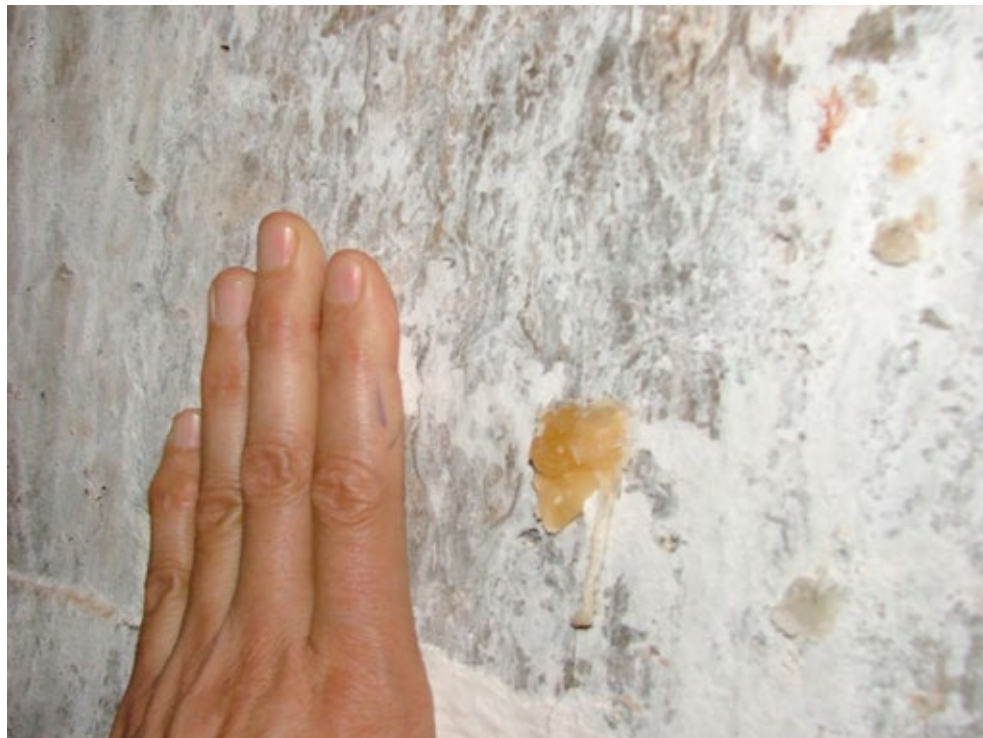
Figura 34. Exsudação de gel álcali-sílica na parede de drenagem de uma barragem afetada pela RAA. Fonte: SBB Engenharia / Banco de Imagens ANA
