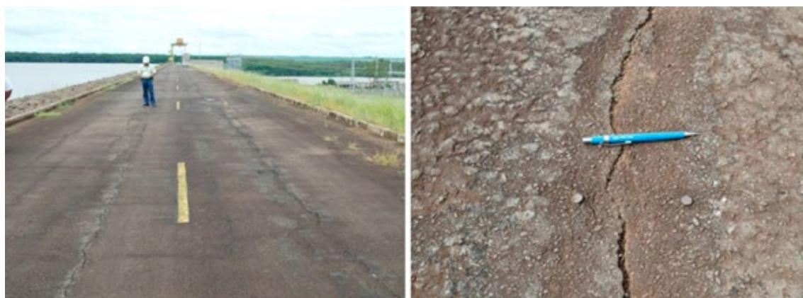
Figura 10. Fissuras longitudinais na crista de uma barragem de terra no Brasil, instrumentada com pares de pinos.
