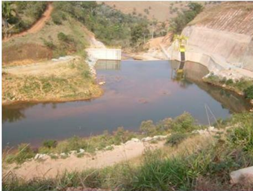
Figura 50. Assoreamento do reservatório de uma PCH no Estado de Minas Gerais.
