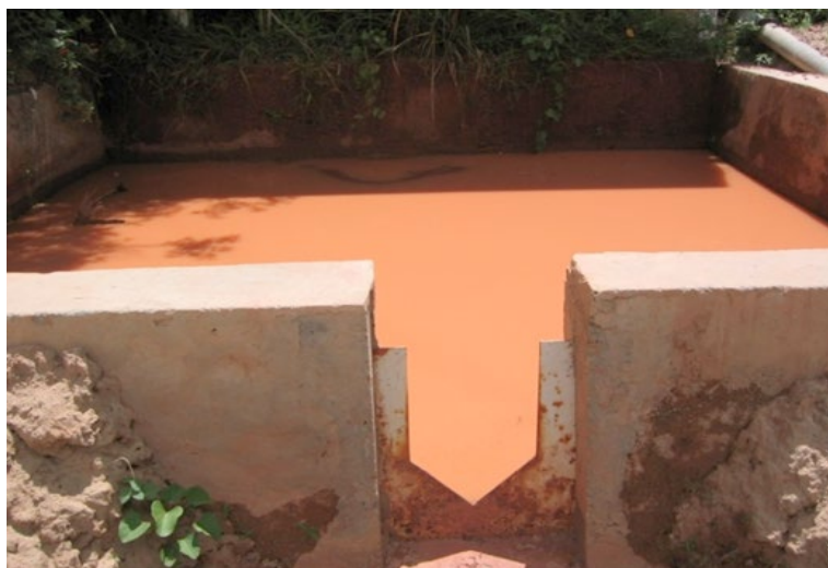
Figura 62. Medidor de vazão. Fonte: COBA, S.A. / Banco de Imagens ANA
