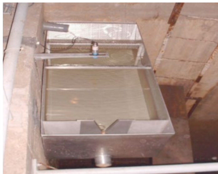
Figura 66. Medidor de vazões com recolha automática. Fonte: COBA, S.A. / Banco de Imagens ANA
