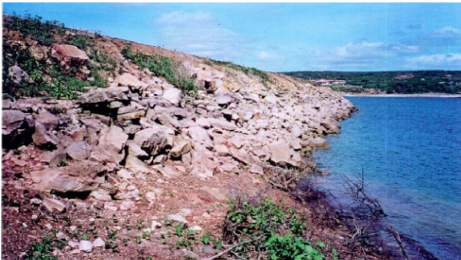
Figura 17. Talude de montante, com região superior sem proteção, e rip-rap mal colocado e deslocado, Jaburu I, CE. Fonte: COBA, S.A. / Banco de Imagens ANA
