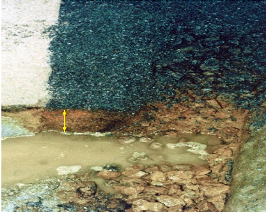
Figura 5. Colmatção das camadas de areia, pedrisco e brita na zona de oscilação do NA (seta) junto ao dreno de pé de uma barragem de terra pela ação de ferro-bactérias.
