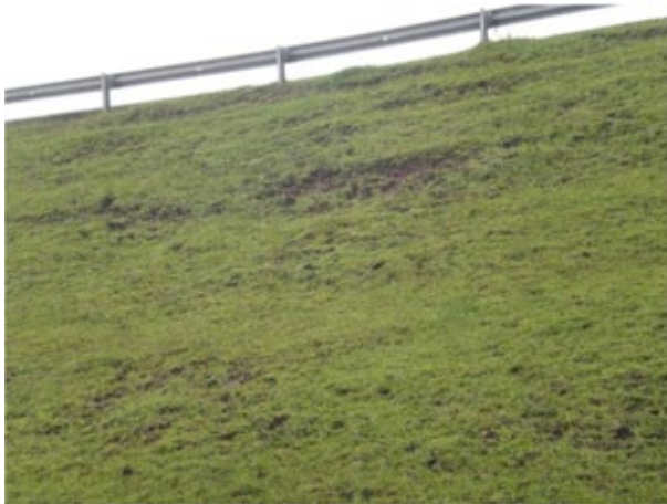
Figura 21. Talude de jusante da barragem com deslizamentos superficiais. Fonte: COBA, S.A. / Banco de Imagens ANA
