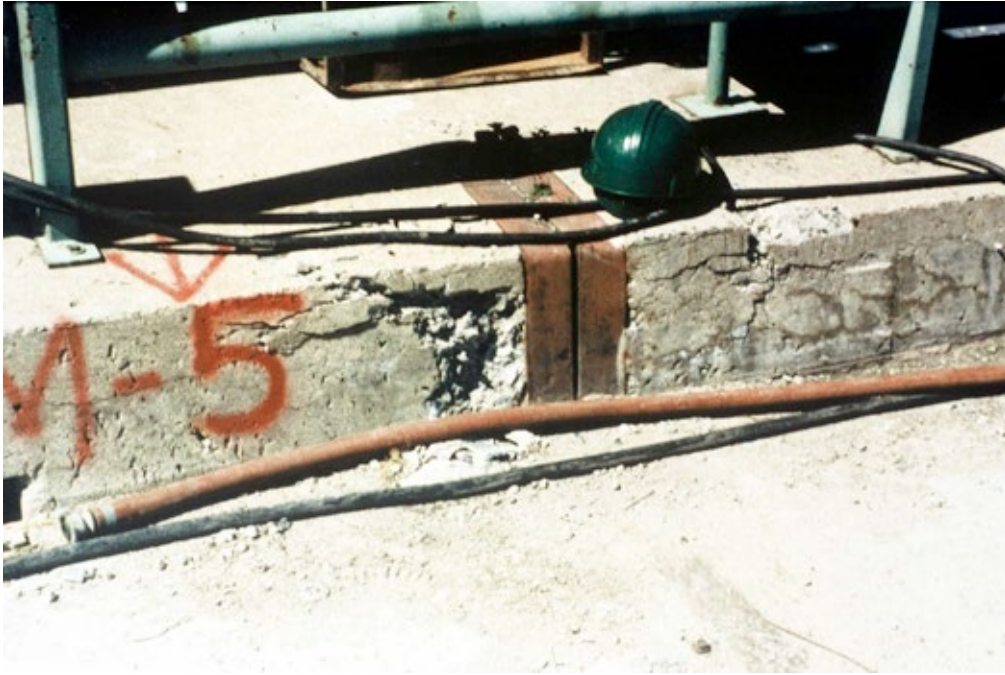
Figura 35. Ruptura do concreto por altas tensões de compressão, na crista do vertedouro da barragem de Mactaquac, no Canadá, afetada pela RAA. Fonte: SBB Engenharia / Banco de Imagens ANA
