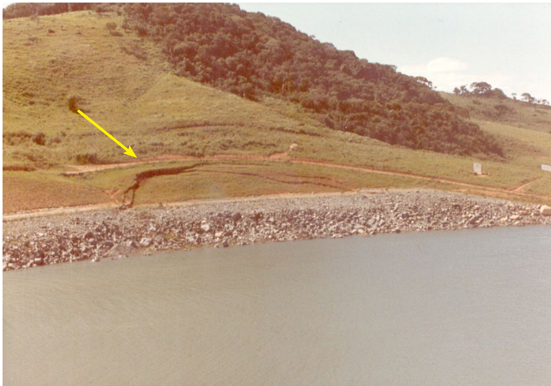
Figura 44. Ruptura do talude lateral do canal de ligação entre reservatórios do Jacareí e Jaguari SP, da SABESP.
