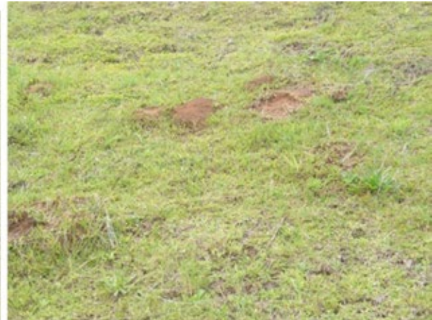
Figura 22. Formigueiros no talude de jusante. Fonte: COBA, S.A. / Banco de Imagens ANA
