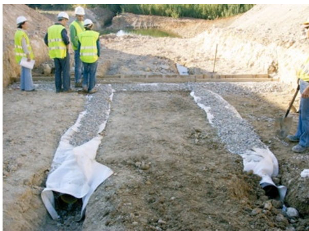
Figura 1. Colocação do sistema de drenagem na fundação de um vertedouro.
