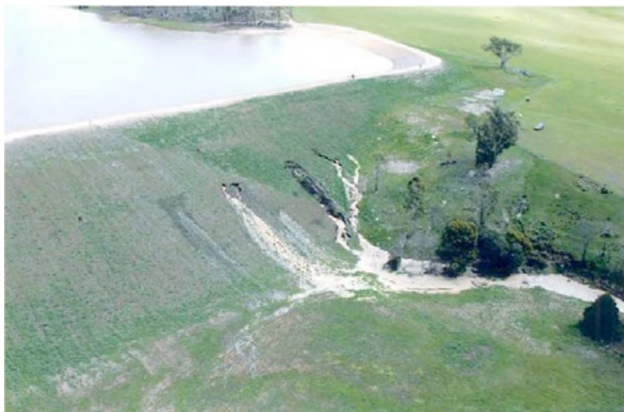
Figura 2. Barragem de terra em processo de piping através do aterro. Fonte: ASDSO, Nov/2008 / Banco de Imagens ANA
