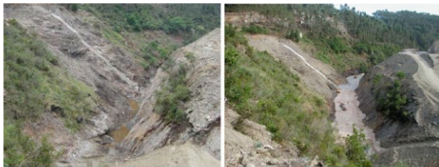
Figura 9. Geometria do vale desfavorável (muito encaixado) para uma barragem de aterro, potencializando a ocorrência de efeito de arco. Fonte: COBA, S.A. / Banco de Imagens ANA
