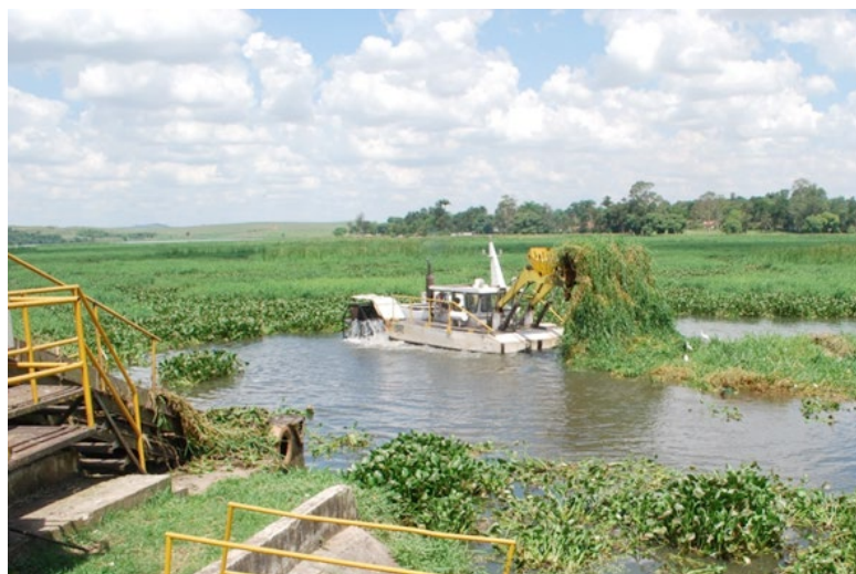
Figura 48. Retirada de material flutuante do reservatório. Fonte: SBB Engenharia / Banco de Imagens ANA
