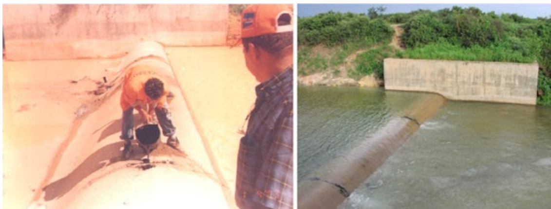
Figura 42. Tratamento de juntas da soleira tipo Creager, Jaburu I, CE. Fonte: COBA, S.A. / Banco de Imagens ANA
