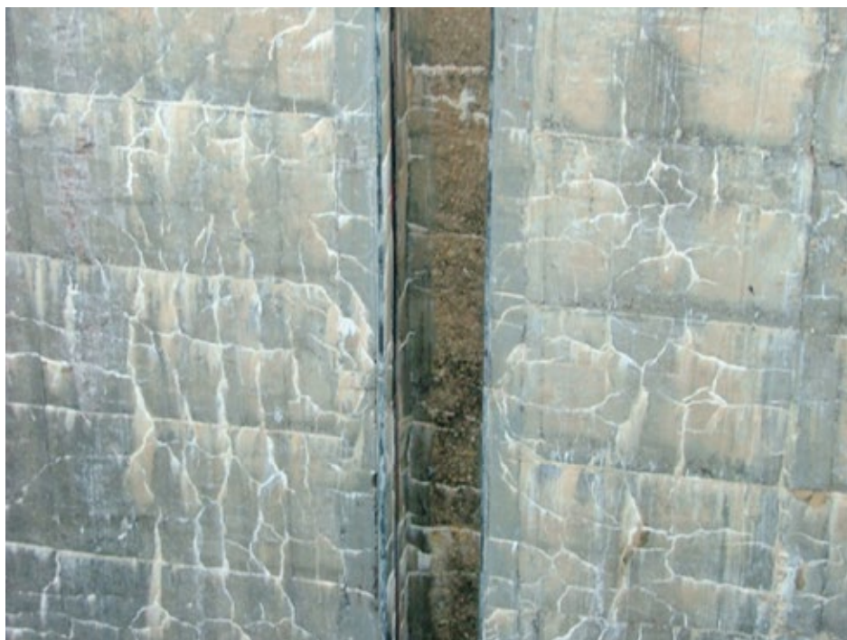
Figura 33. Fissura tipo “mapa” provocadas pela RAA- Reatividade Álcali-Agregado na parede interna de uma eclusa, no Brasil. Fonte: SBB Engenharia / Banco de Imagens ANA
