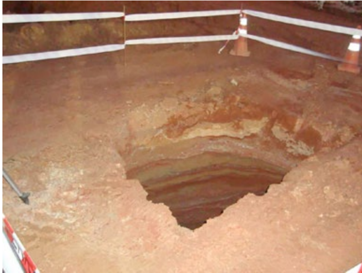
Figura 16. Afundamento devido a erosão interna, observado no aterro durante os trabalhos de reabilitação da barragem do Gove, Angola. Fonte: COBA, S.A. / Banco de Imagens ANA
