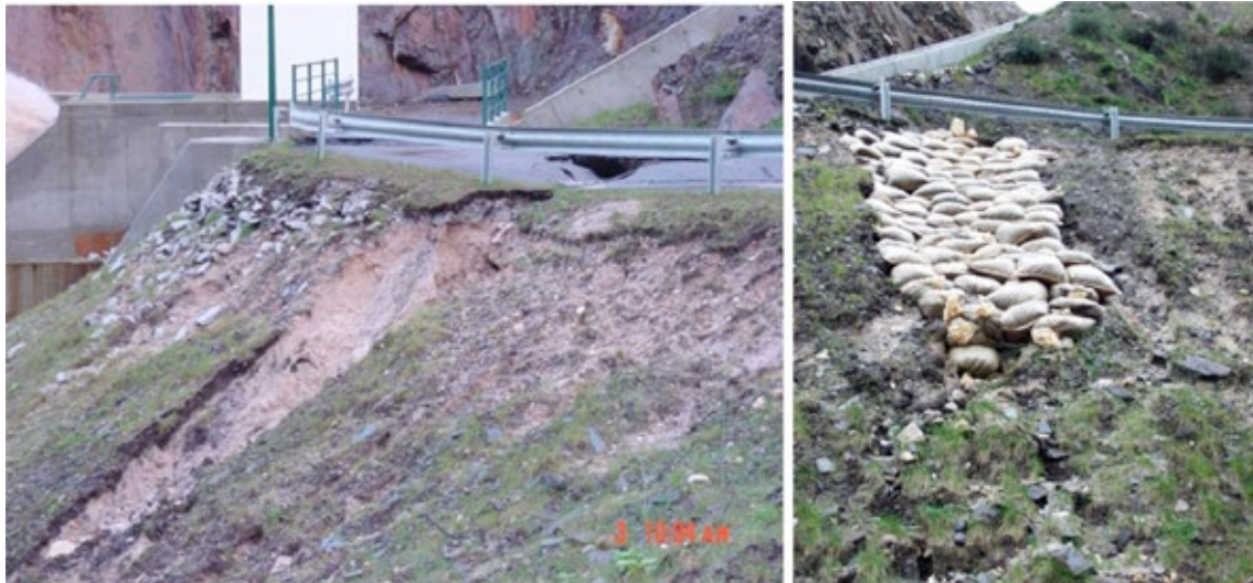
Figura 14. Deslizamentos do talude de jusante e reparação de emergência com sacos de areia. Fonte: COBA, S.A. / Banco de Imagens ANA
