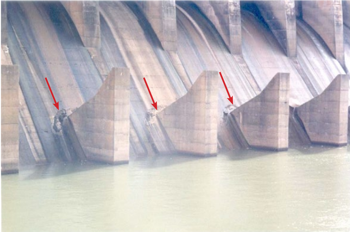
Figura 39. Erosão por cavitação junto aos blocos defletores na calha do vertedouro de Ilha Solteira, SP/MS.
