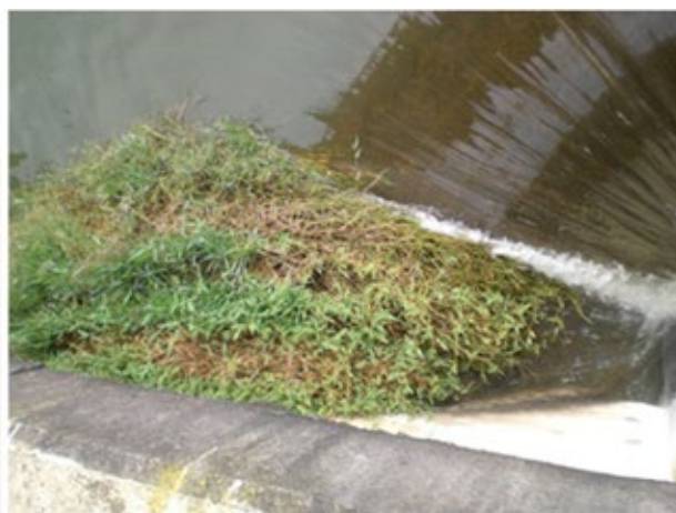
Figura 47. Vegetação a ser arrastada para o interior do poço do vertedouro.
