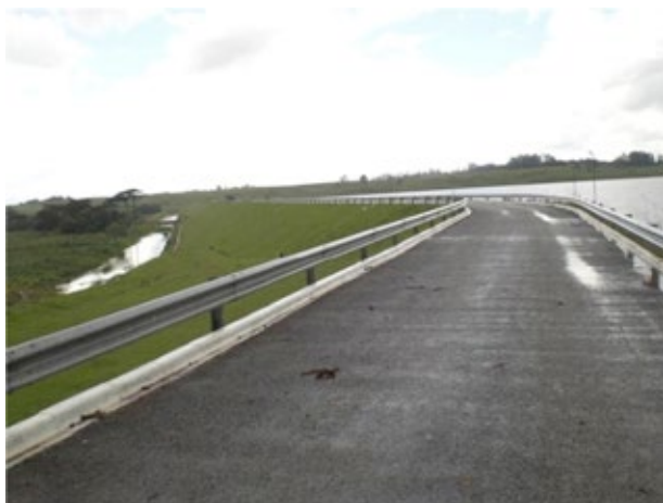
Figura 18. Água acumulada no pavimento, resultante de drenagem deficiente.
