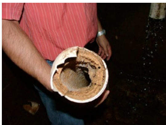
Figura 28. Dreno de uma barragem em CCR parcialmente obstruído pela deposição de carbonato de cálcio.
