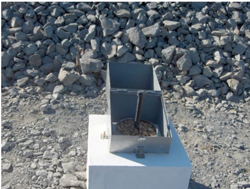
Figura 68. Piezômetro protegido com maciço de concreto e tampa metálica. Fonte: COBA, S.A. / Banco de Imagens ANA
