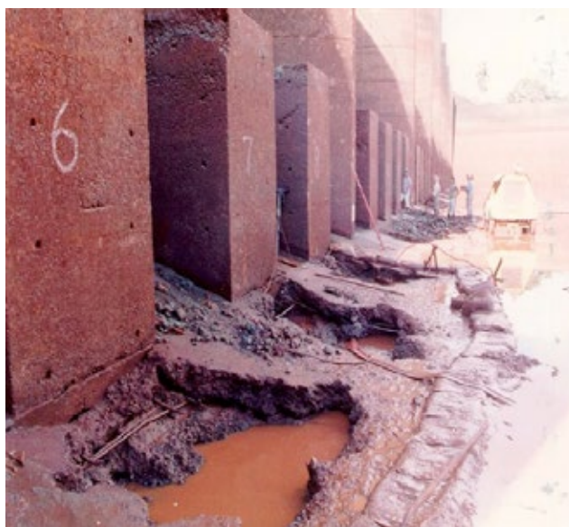
Figura 38. Erosão por cavitação a jusante dos blocos de dissipação no vertedouro da barragem de Porto Colômbia SP/MG.
