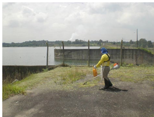
Figura 20. Ação de manutenção com corte de vegetação.
