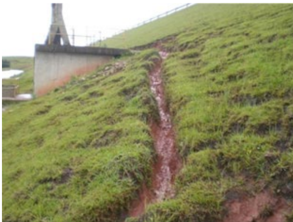
Figura 23. Erosão provocada pela água da chuva, correndo em caminhos abertos por pessoas e animais. Fonte: COBA, S.A. / Banco de Imagens ANA
