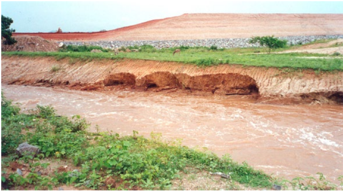
Figura 37. Erosão do talude do canal extravasor da descarga de fundo/tomada de água na barragem de Aracoiaba, CE.
