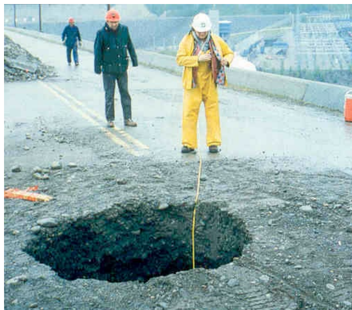
Figura 15. Afundamento (Sinkhole) na crista da barragem de Bennett, Canadá. Water Power & Dam Construction, Fev 1997 / Banco de Imagens ANA
