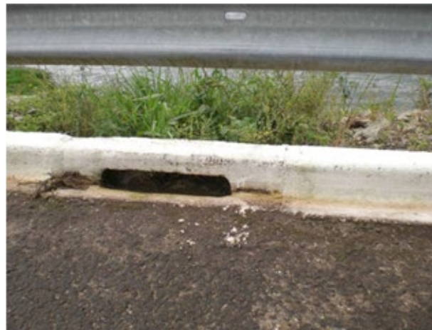
Figura 19. Saída da água obstruída, necessitando manutenção.
