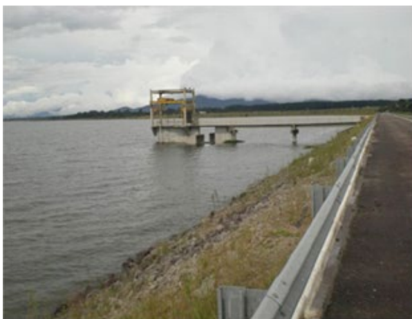
Figura 46. Vertedouro em poço, em funcionamento.
