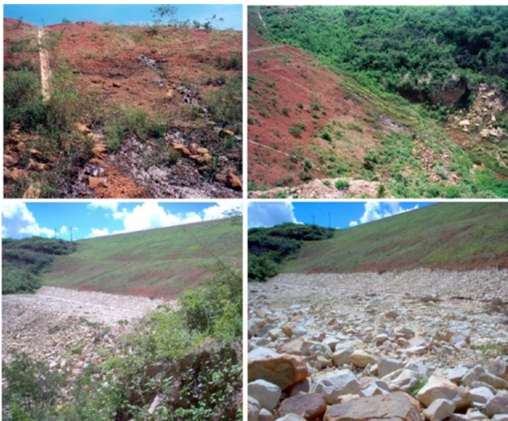
Figura 7. Surgências de água no talude de jusante e reabilitação (fotos inferiores) com maciço estabilizador do pé de jusante e tapete drenante sobre esporões afastados 10 m uns dos outros na Barragem de Jaburu I, CE.
