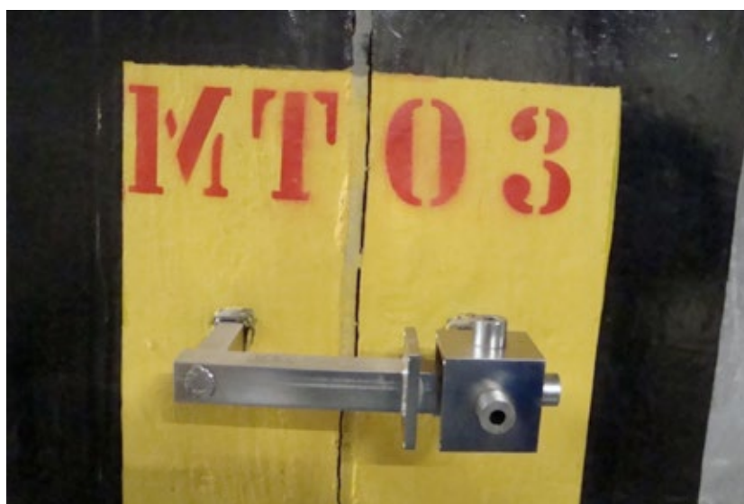
Figura 65. Detalhe do medidor triortogonal instalado na parede da galeria de drenagem de uma barragem de concreto. Fonte: SBB Engenharia / Banco de Imagens ANA
