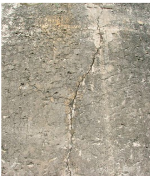
Figura 31. Fissura subvertical de origem térmica ( e = 2,0 \text{ mm} ), no paramento de jusante de uma barragem tipo gravidade. Fonte: SBB Engenharia / Banco de Imagens ANA
