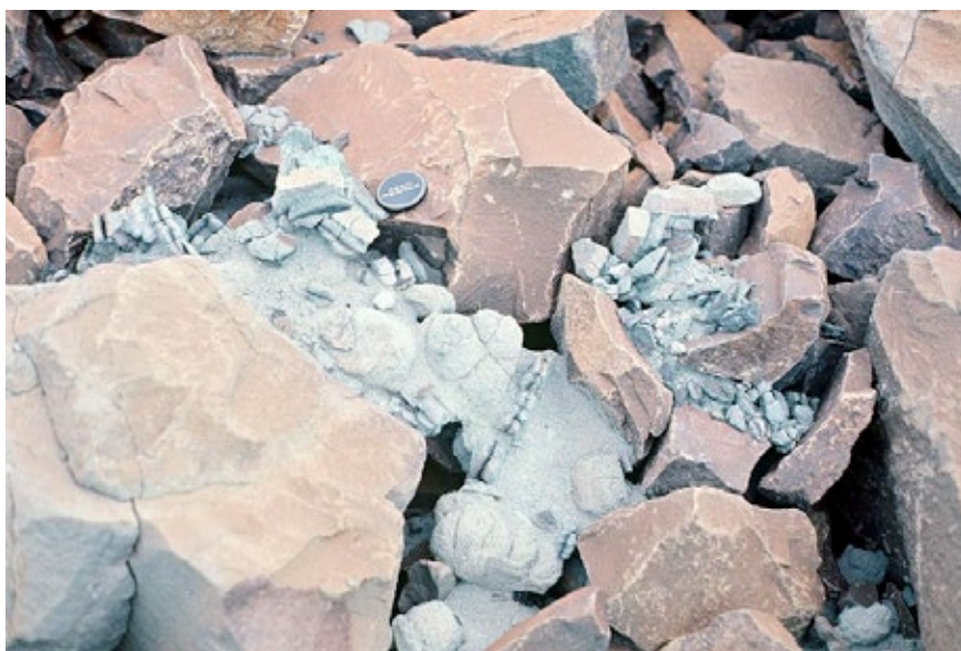
Figura 3. Desagregação de blocos de basalto no rip-rap de uma barragem de terra no Brasil. Fonte: SBB Engenharia / Banco de Imagens ANA
