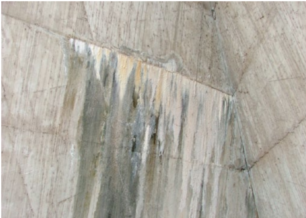
Figura 30. Infiltração com carbonatação através de uma junta entre camadas de concretagem no paramento de jusante de uma barragem gravidade-aliviada. Fonte: SBB Engenharia / Banco de Imagens ANA
