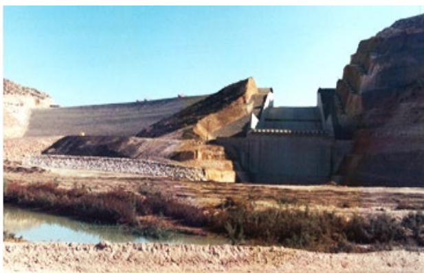
Figura 7. Barragem de Gargar (Argélia). (Fonte: COBA, S.A.)
