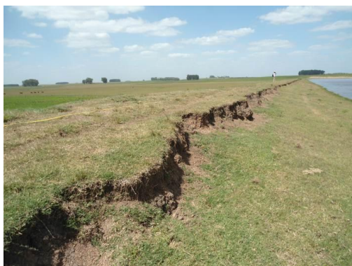
Figura III. 10 – Erosão do paramento montante sob a ação das ondas
