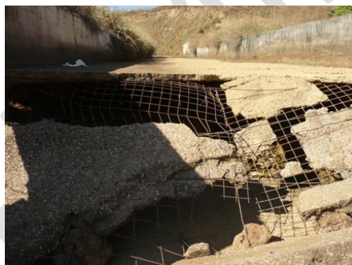
Figura III. 16 – Danos estruturais severos na soleira do vertedouro
