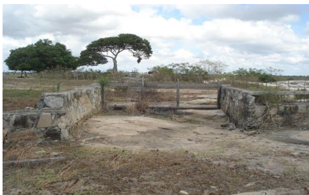
Figura III. 17 – Obstrução da soleira do vertedouro
