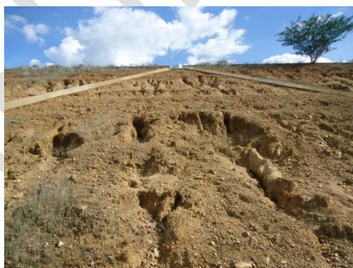
Figura III. 13 – Intenso ravinamento no paramento de jusante
