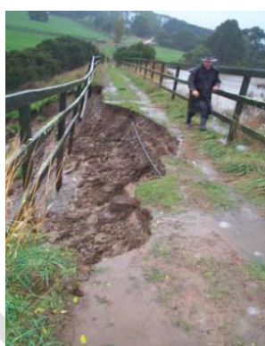
Figura III. 1 – Erosão do maciço de jusante e do coroamento após galgamento da barragem (SMEC, 2005)
