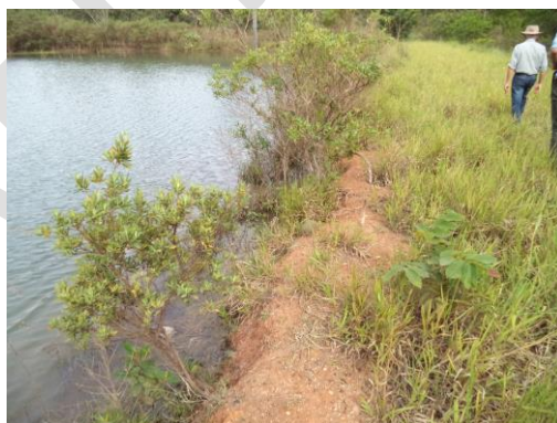
Figura III. 2 – Borda livre insuficiente
