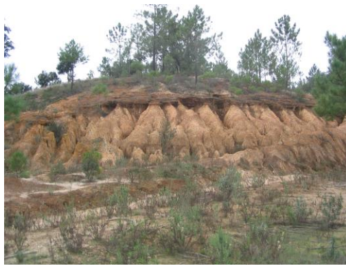
Figura III. 19 – Forte ravinamento dos taludes do reservatório
