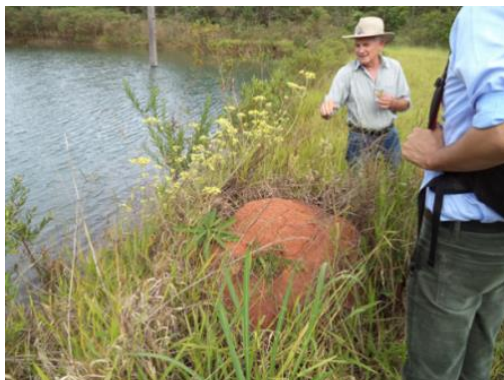
Figura III. 14 – Cupinzeiro no coroamento da barragem
