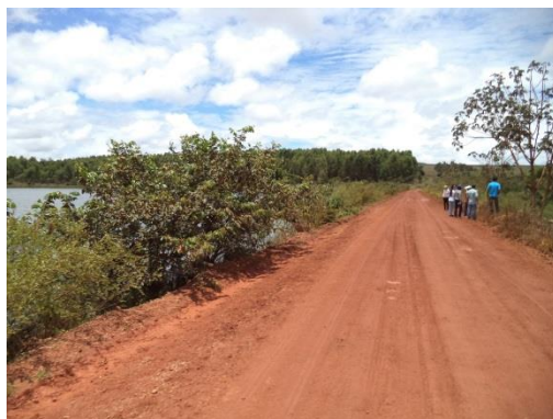
Figura III. 12 – Vegetação de tamanho excessivo no paramento de montante e de jusante
