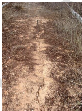
Figura III. 7 – Trinca longitudinal no coroamento
