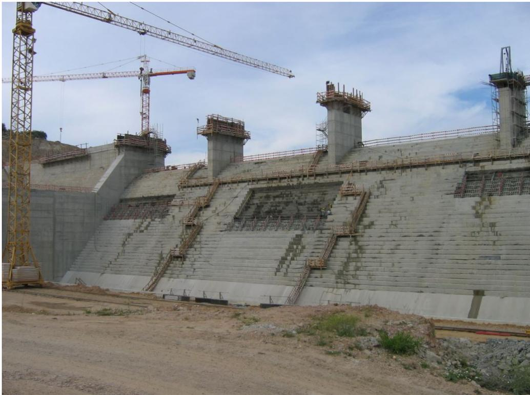
**Figura 28. Barragem de concreto compactado a rolo (CCR) (Barragem de Pedrógão, Portugal). (Fonte: LNEC)**
