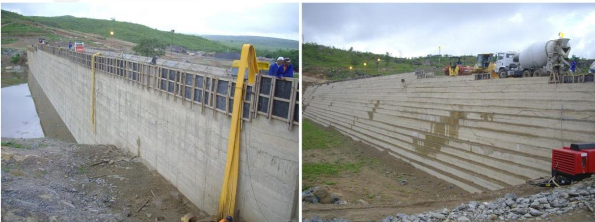
**Figura 27. Barragem de concreto compactado a rolo (CCR). Barragem do Mamoeiro, CE.**
