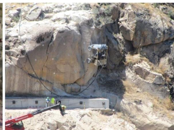
**Figura 9. Viga de ancoragem ativa.**
