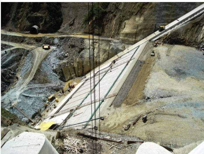
**Figura 17. Construção de uma barragem de enrocamento com face em concreto e plinto de fundação. (Fonte: COBA, S.A.)**
