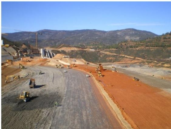
**Figura 19. Aterro zonado. Operações de espalhamento e de compactação.**
