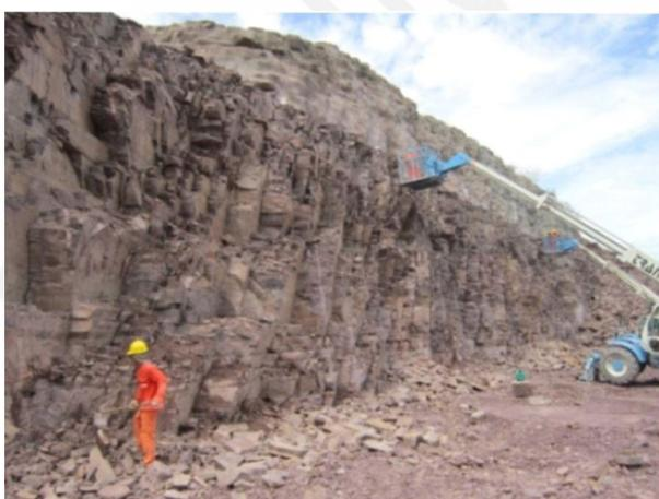
**Figura 6. Remoção de blocos soltos.**
