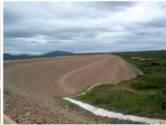
**Figura 15. Proteção do talude de jusante em cascalho.**
