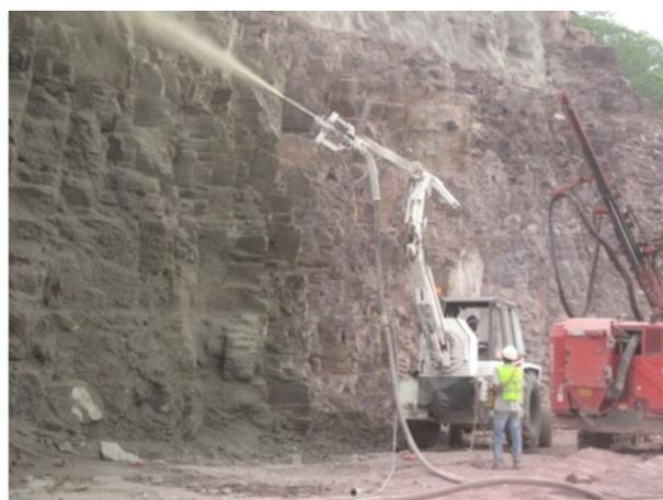
**Figura 7. Projeção de concreto.**
