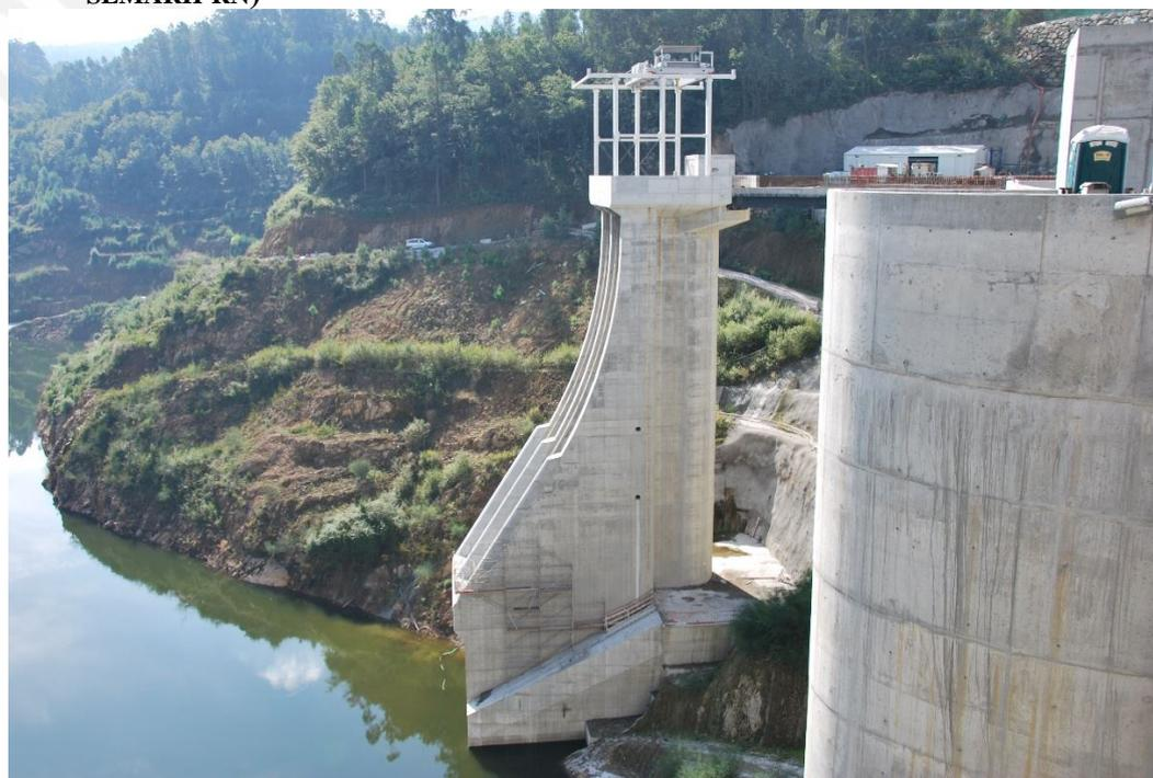
**Figura 35. Tomada de água em torre, adjacente à barragem de concreto. Barragem de Ribeiradio, Portugal. (Fonte: Coba, S.A.)**
