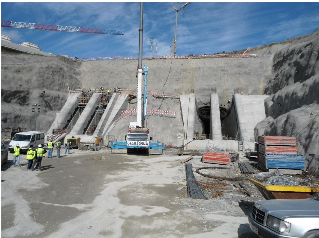
**Figura 36. Tomadas de água numa das vertentes seguida de túnel. Barragem do Baixo Sabor, Portugal. (Fonte: Coba, S.A.)**
