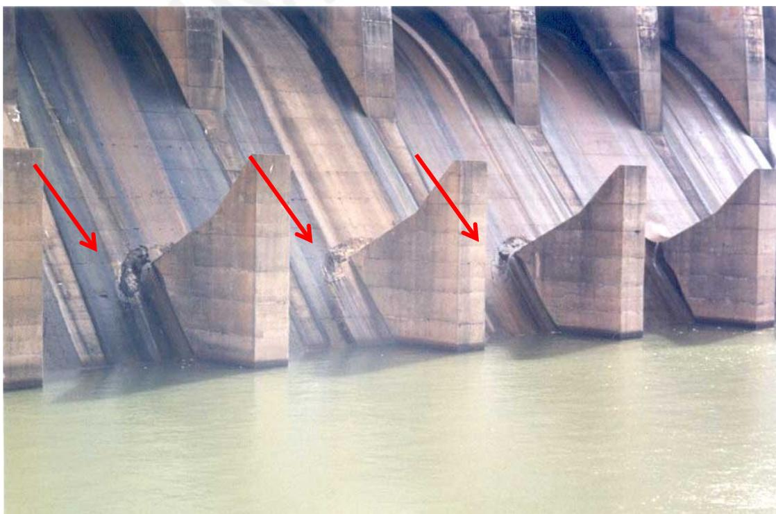
**Figura 39. Exemplo de cavitação no concreto por tipo jato cavitante. (Fonte: SBB, Engenharia)**
