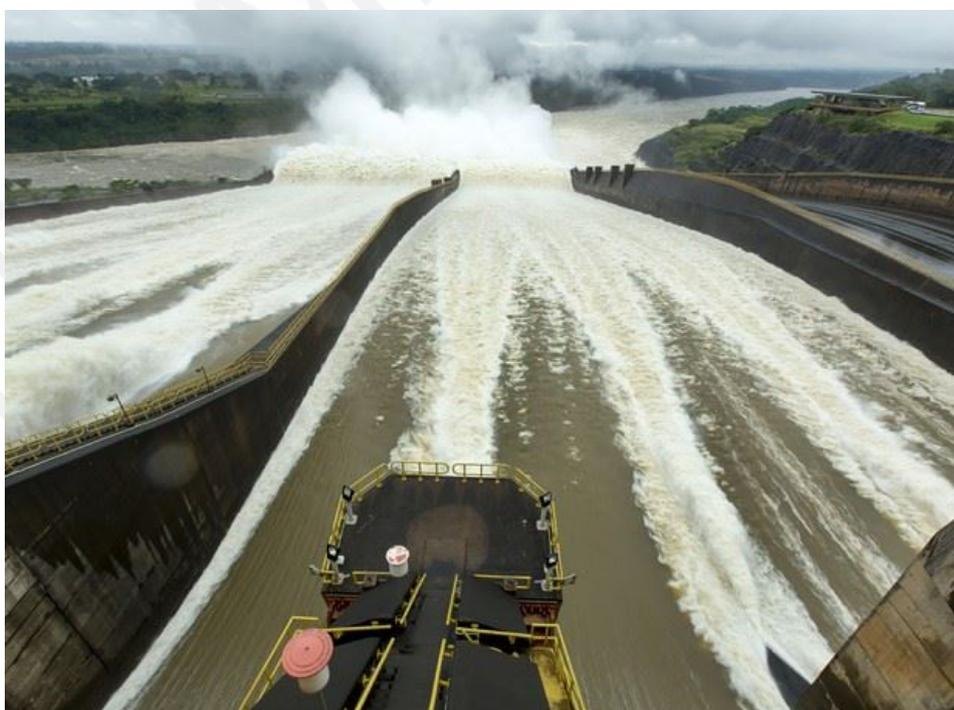
**Figura 37. Formação de ondas estacionárias de frente abrupta na barragem de Itaipu. Vista lateral e vista de montante. (Fonte: SBB, Engenharia)**
