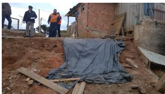
Deslizamento em Araucária no dia 17 de junho de 2015. Parte do Muro cedeu em função das chuvas, colocando em risco 3 residências – Ocorrência 194/2015.
