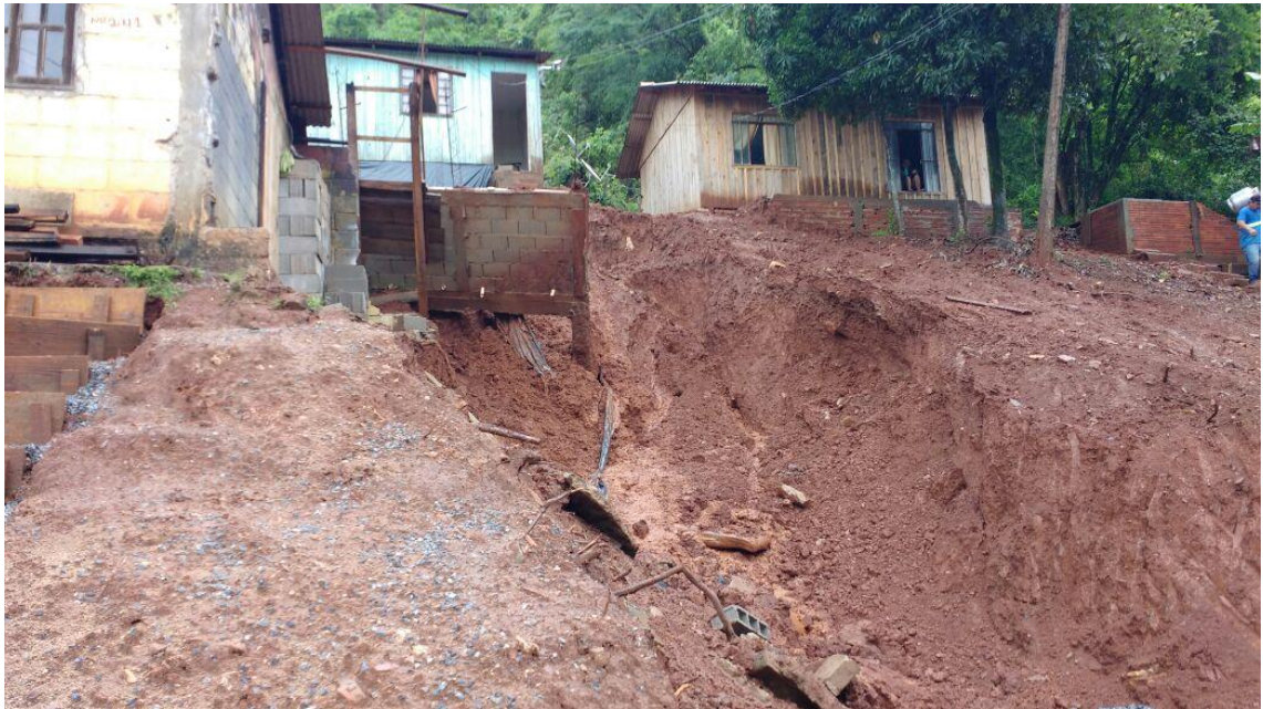
Deslizamentos no município de Adrianópolis em 28/12/2017. Fonte: SISDC.
